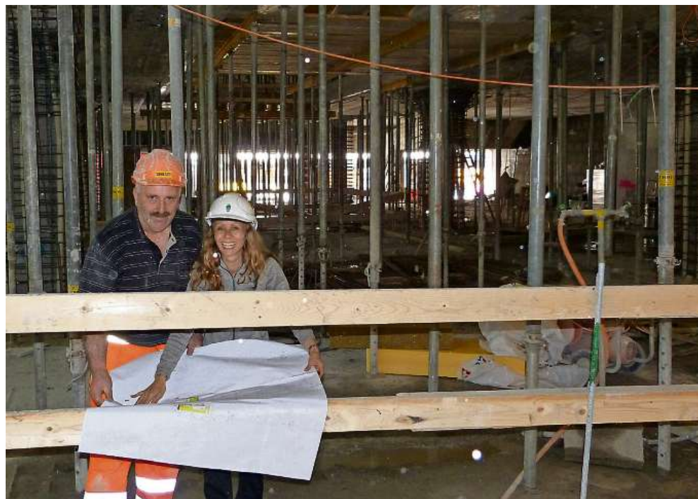
Im Stützenwald, der das Erdgeschoss im Moment noch auszeichnet, bespricht Chef-Bauleiterin Jeannette Wehrli mit Polier Rami Sulymani die Pläne.
