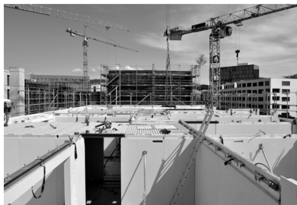
Montage der Decken bei Haus 4
