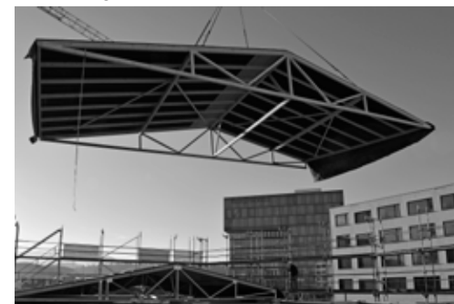
Versetzen Notdachelemente
